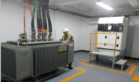
INSTALLATION TRAFO 1250 KVA
