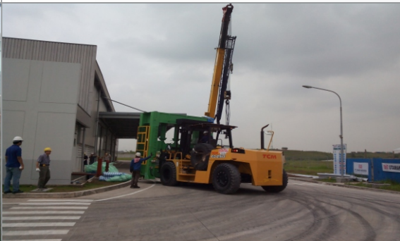
UNLOADING PRESS 200 TON MACHINE
